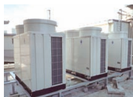
静岡工場事務棟に設置された高効率ビル用マルチエアコン(写真は室外機)。
