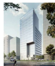
新青山ビル 24年1月竣工(予定)
