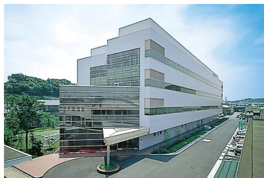
ポーラ化成工業 本社・横浜研究所
